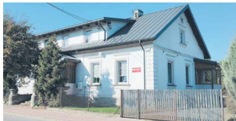
Stary budynek przedszkola
