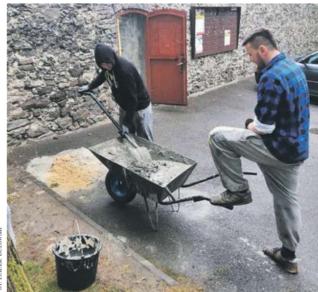
Strażacy naprawiają mur klasztorny, od strony głównego wejścia
