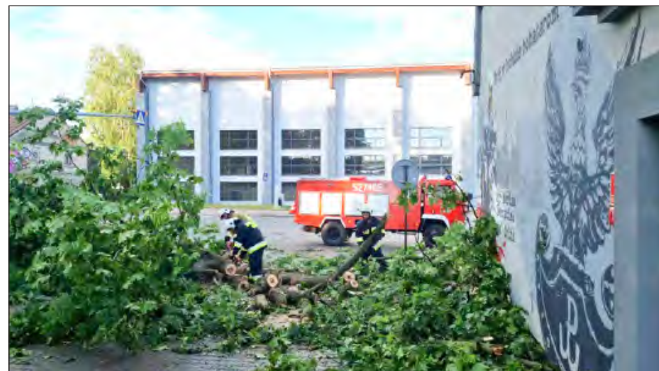
❖ Jedno z drzew pobliskiego parku podczas ubiegłorocznej nawałnicy, która przeszła nad Rykami, upadło na dworzec PKS niszcząc ścianę, na której namalowany jest mural (fot. OSP Budki Kruków)
