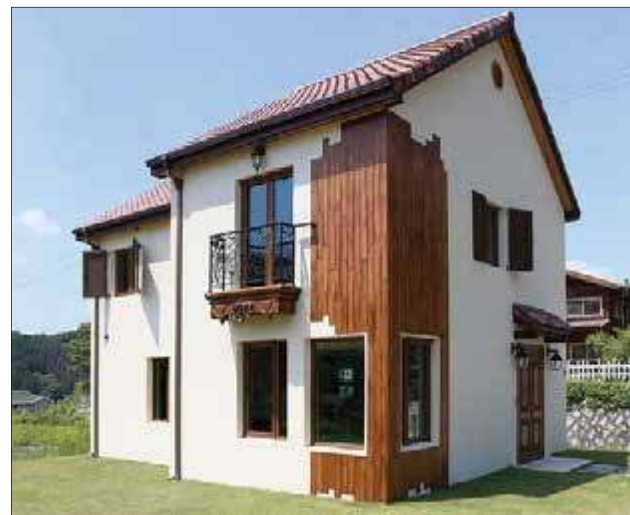
Za pomocą drewnianych elementów można zmienić proporcje budynku
