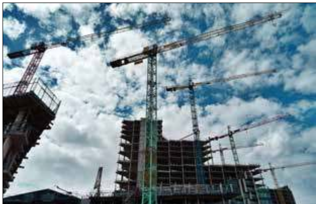
Nowoczesny plac budowy to miejsce, w którym człowiek powinien współpracować z maszynami zaawansowanymi technologicznie
