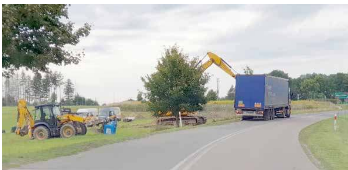
Początek budowy. Ciężki sprzęt na miejscu pojawił się wczoraj, w poniedziałek
