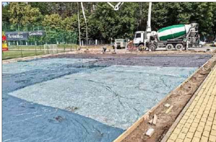
W sierpniu przyszłego roku w tym miejscu stał będzie skatepark.
