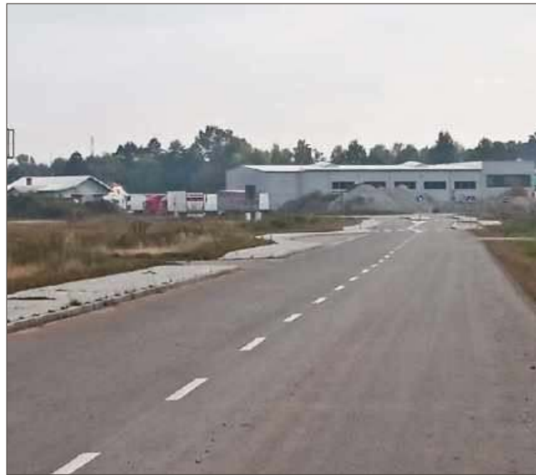
Budowa siedzimy firmy Demi Poland już ruszyła.
