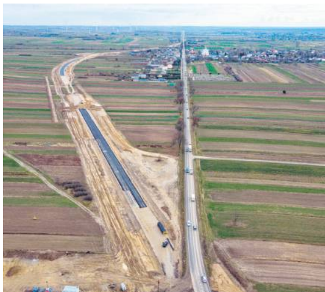
W Dzwoli (pow. janowski) trwa budowa obwodnicy. Zamość i Szczepieszyn jeszcze czekają. Fot. GDDKiA Lublin
