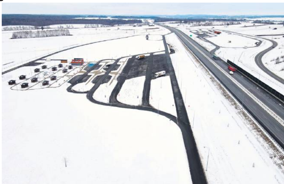
Para MOP-ów Słodków przy drodze S19. Mogą one być wzorem dla tych, które powstaną na obwodnicy Tomaszowa. Fot. GDDKiA
