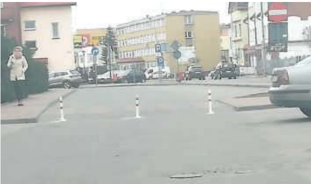
Zgodnie z zapowiedziami od rana 19 lutego na przejeździe przy „Grzybku” zostały ustawione barierki ograniczające ruch. Przejazd został zablokowany
