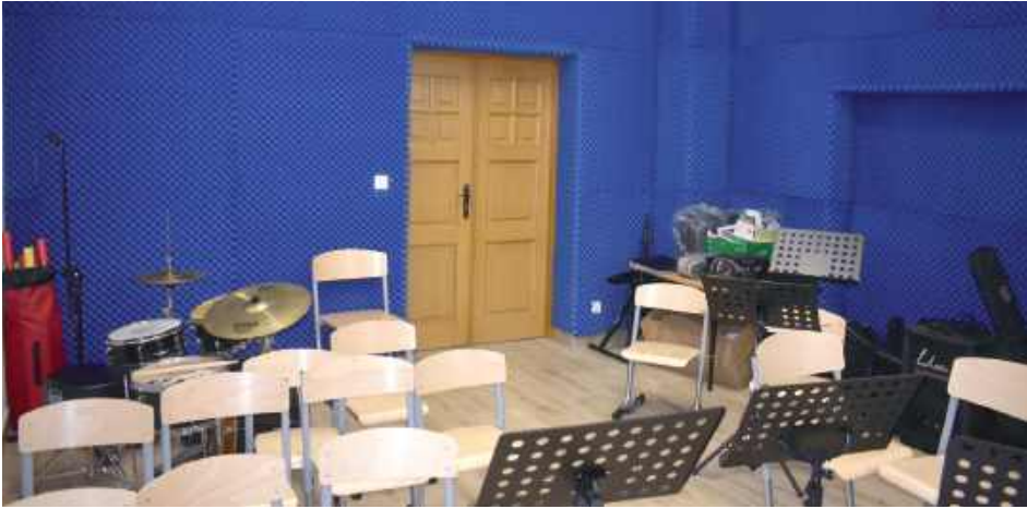
W sali muzycznej zamontowano piankowe panele akustyczne, które ograniczą dźwięki z innych pomieszczeń. W tym miejscu ma również powstać studio nagraniowe
