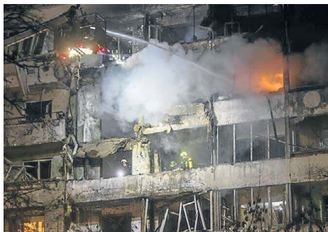
Ukraińscy ratownicy pracują na miejscu rosyjskiego ataku na dziewięciopiętrowy budynek mieszkalny w Kijowie
