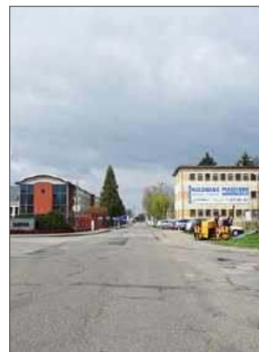
Te tereny wymagają przebudowy.
