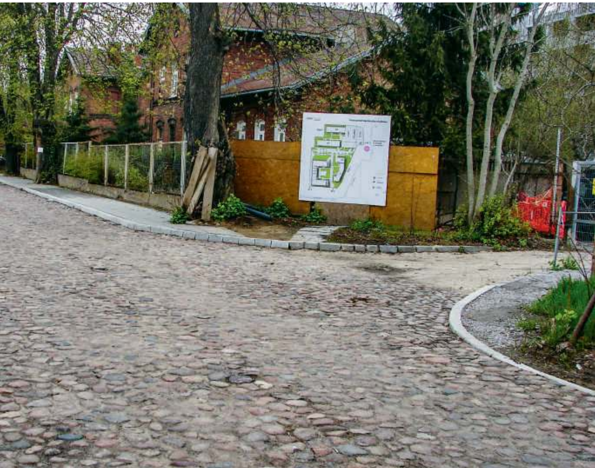
Fragment wyremontowanej nawierzchni ul. Armatniej. | fot. Janusz Sujecki/Gazeta Polska
