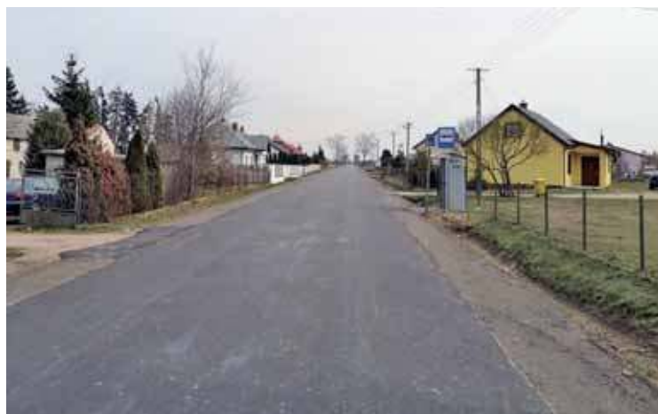
Fragment zmodernizowanej drogi
