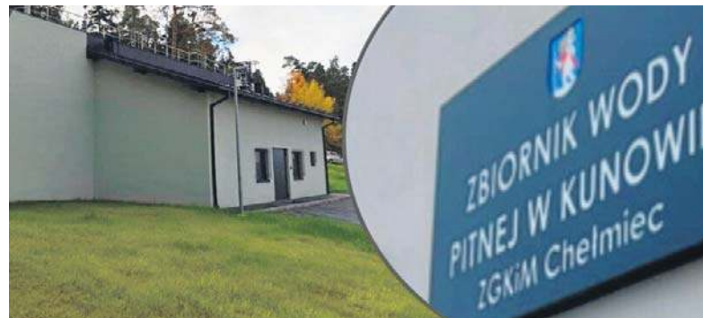
Dobiegły końca prace związane z budową zbiornika wody pitnej oraz całą infrastrukturą towarzyszącą na terenie gminy Chełmec
