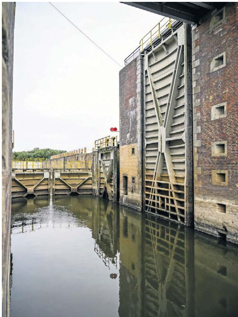
Potężne wrota przeciwpowodziowe chronią okolicę przed wysokimi stanami na Wiśle. Obecnie to nie grozi
