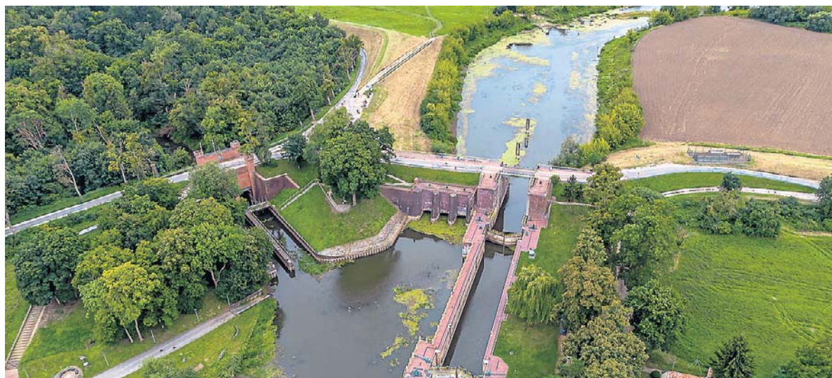
Węzeł wodny w Białej Górze. Po lewej stara śluza z 1852 r., po prawej stopień wodny z lat 1912-1916
