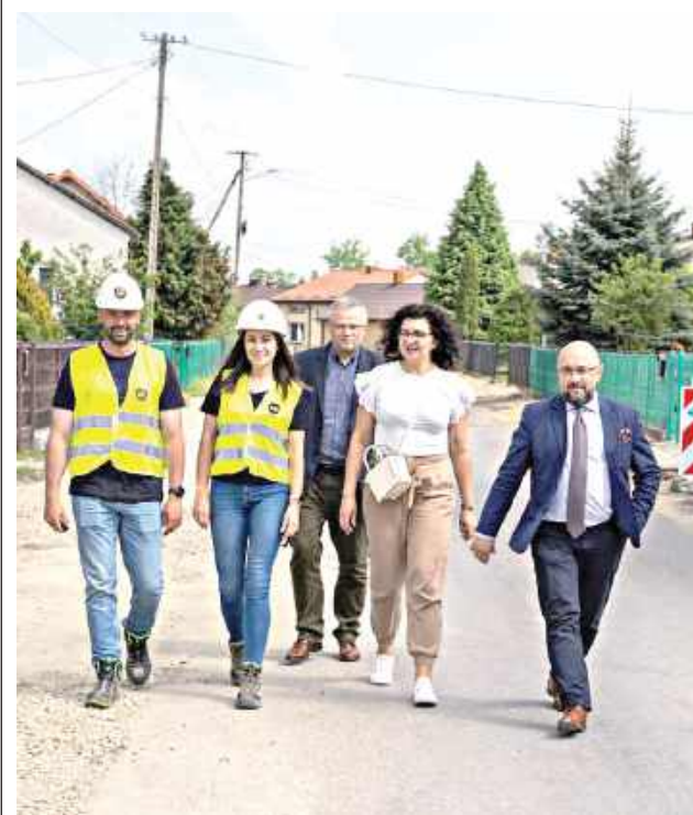
Jak przebiegają prace, sprawdzali w środę wójt Jarosław Budka wraz z radną Małgorzatą Bartkiewicz, zastępcą wójta Krzysztofem Dudzińskim oraz kierownik Emilią Wasak, którzy odwiedzili plac budowy w Chlewiskach
