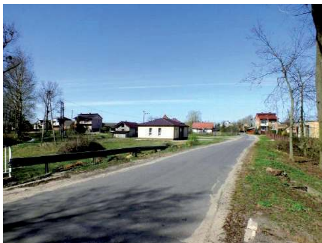
Jeszcze w tym roku ruszą prace remontowe na drodze prowadzącej do Zagóździa
