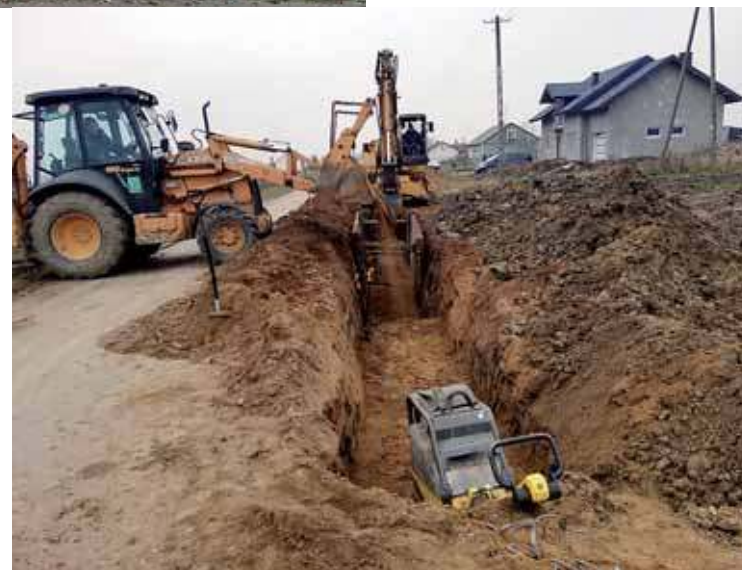
Budowa kanalizacji w Karwaczu
