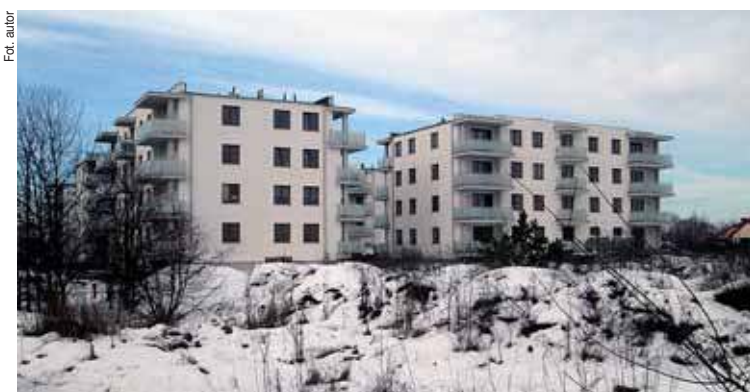
Mława jest wielkim placem budowy
