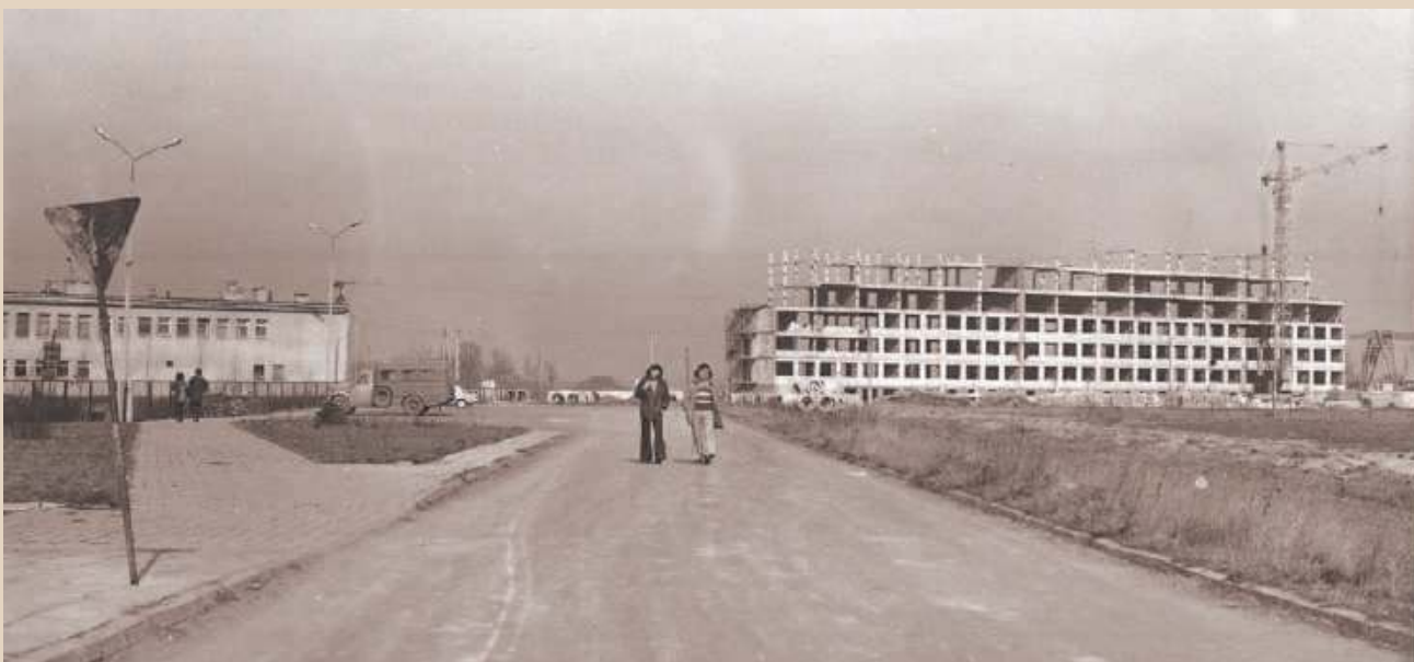
1975 - zdjęcie rozpoczętej budowy szpitala przy ul. Baczyńskiego, od ul. ks. Franciszka Kutrowskiego
