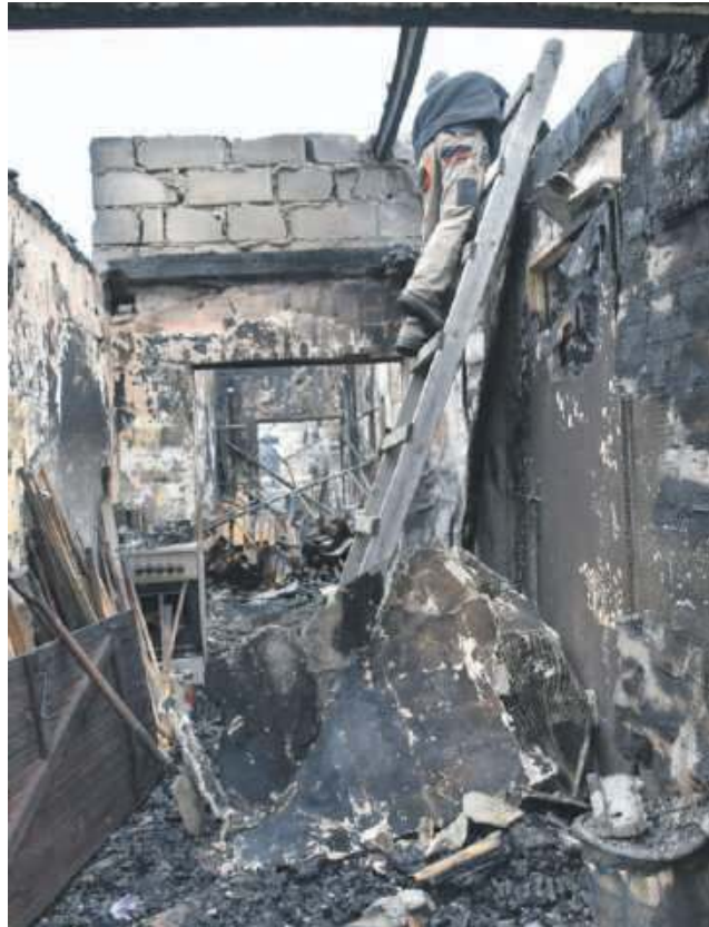
Jako pierwszy zapalił się drewniany dach pokryty papą
