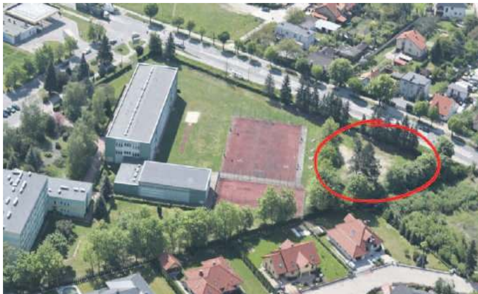
W tym miejscu, przy Centrum Kształcenia Zawodowego i Ustawicznego w Oławie, samorząd zbuduje warsztaty edukacyjne, zamiast obecnych, znajdujących się pomiędzy ul. Żołnierzy Armii Krajowej i 11 Listopada
