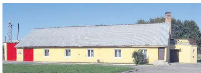
Przygraniczne Centrum Kultury i Rekreacji w Dołhobyczowie jesienią przyszłego roku przeprowadzi się do nowej siedziby. Tej obecnej nie dało się już remontować.
