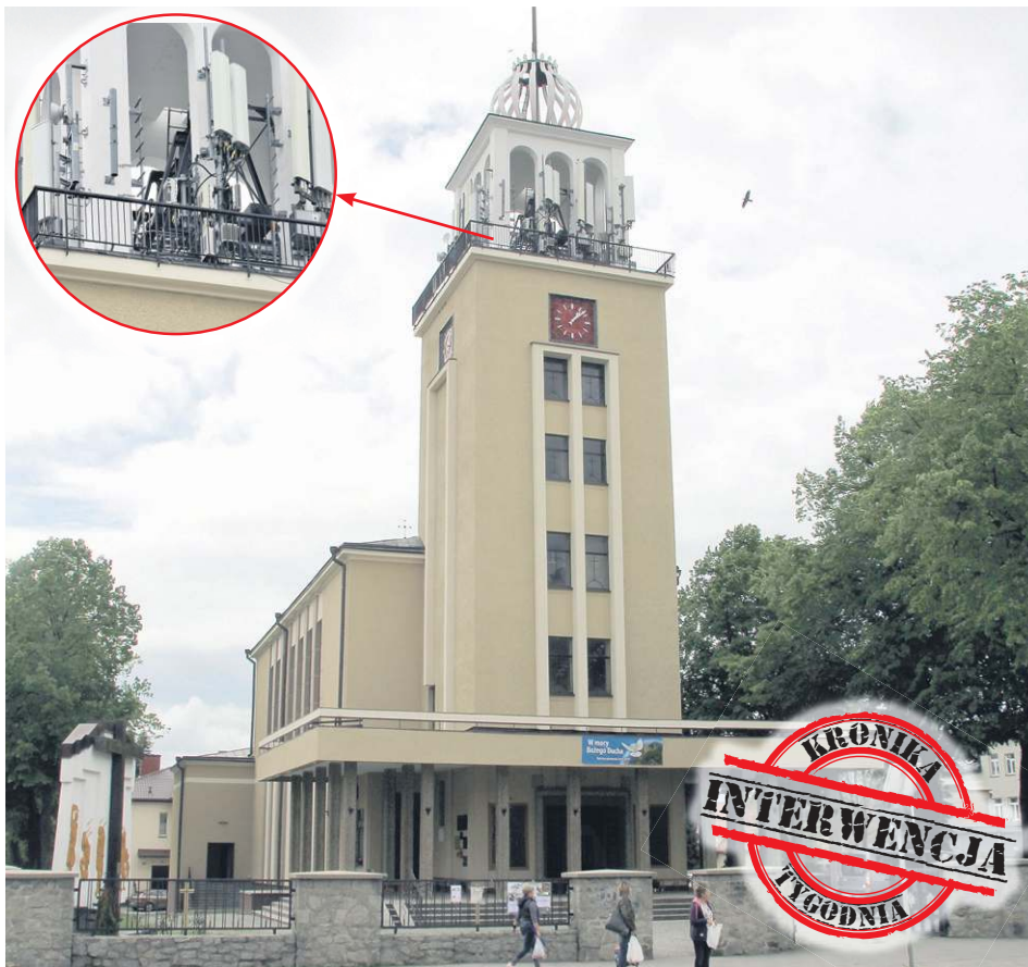
Kościół pw. św. Krzyża w Zamościu i urządzenia zamontowane na kościelnej wieży.
