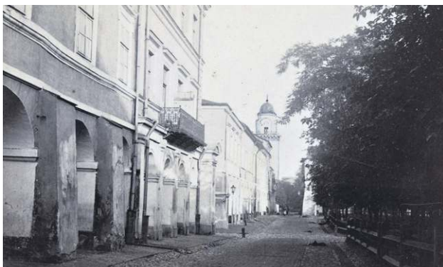
Na początku XX w. ulica Staszica była wyraźnie zaznaczona.
