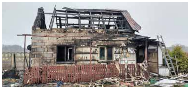
Straty spowodowane pożarem domu są bardzo duże
