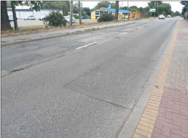
Dokumentacja jest gotowa i wiadomo, jak przebiegnie remont
