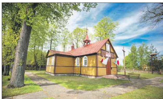
Drewniany budynek kościoła został wybudowany blisko sto lat temu i jest dumą wiernych parafii rzymskokatolickiej pw. Matki Bożej Anielskiej w Horoszkach Dużych
