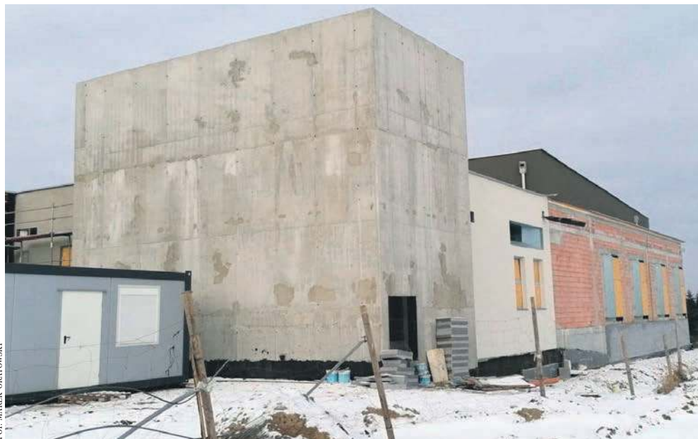
Zakończenie budowy basenu nastąpi wiosną 2022 roku
