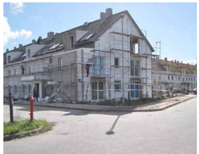
Prace przy budowie mieszkań przebiegają bez zakłóceń, obecnie trwa już wykańczanie bloków z zewnątrz i wewnątrz
