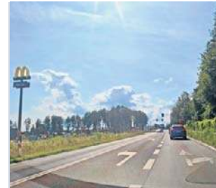
Przejścia ciągle brak
