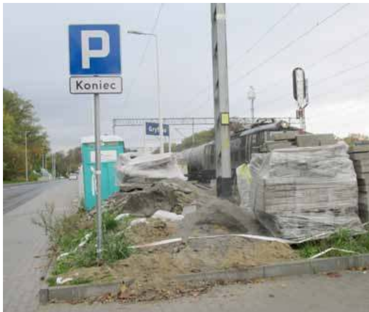
Widoczna na naszym zdjęciu tojtojka jest dowodem, że roboty jeszcze nie skończone
