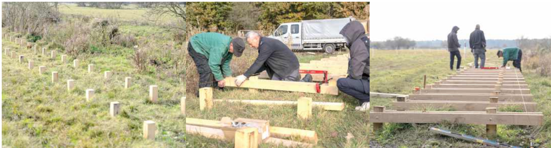
Budowa kładki na łęczyńskich błotach
