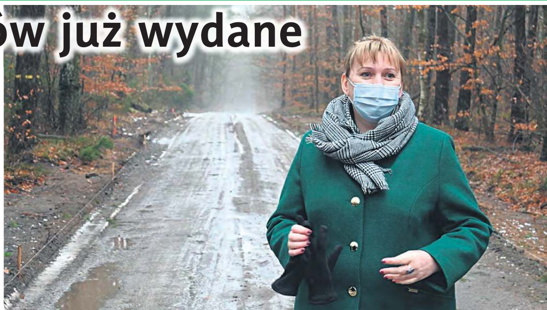
– Wykonawca przygotował całą podbudowę drogi [...]. Firma wróci na plac budowy najprawdopodobniej wczesną wiosną – informuje Joanna Jastak.
