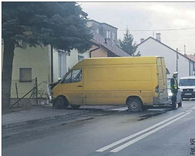
W wyniku uderzenia uszkodzony został także budynek.
