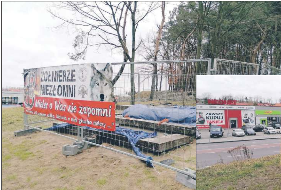
Pomnik ma już betonową podstawę.
