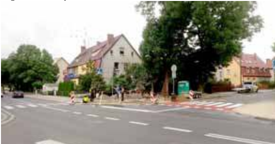
Od jakiegoś czasu trwają w tym miejscu prace mające na celu poprawę bezpieczeństwa w ruchu pieszych i rowerzystów
