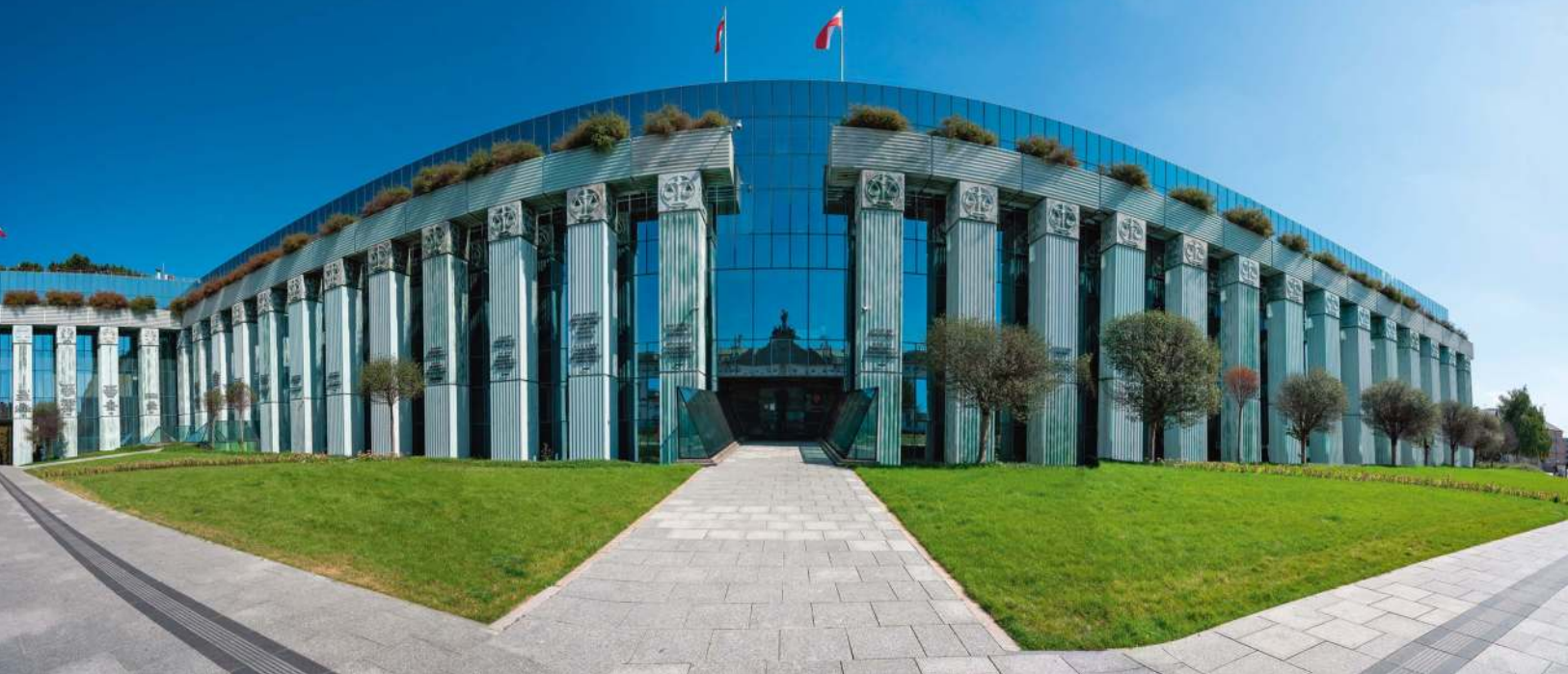
Gmach Sądu Najwyższego w Warszawie, arch. Marek Budzyński. • Poniżej: Nieistniejący już dom handlowy Solpol we Wrocławiu, arch. Wojciech Jarząbek.
