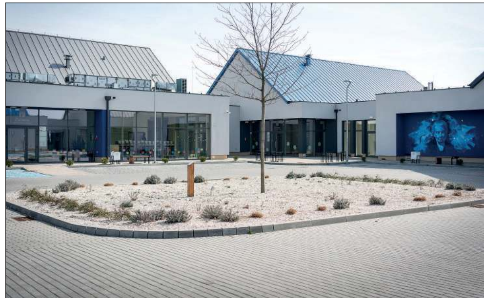
■ Placówka Montessori w Kornicach to kompleks 5 budynków połączonych korytarzami
