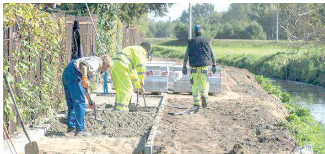
Jest już monitoring i oświetlenie, a teraz powstaje chodnik
