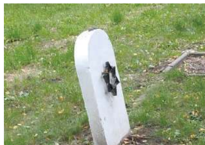
Mogiły w Kwaterze Żydowskiej przed remontem.
