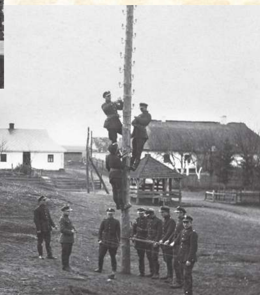
Zakładanie linii telefonicznej w 4. Batalionie KOP „Dederkały”.
