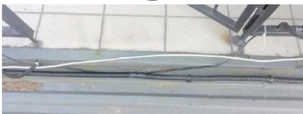
Miejsce złączenia dwóch osłon z przewodem wysokiego napięcia owinięto taśmą samoprzylepną.
