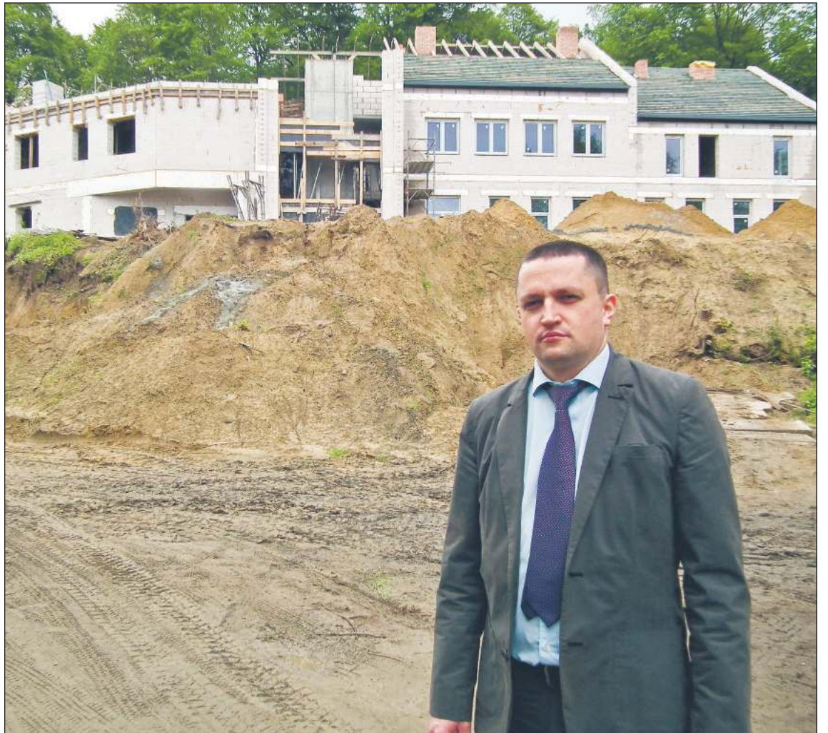
- Przychodnia już stoi - cieszy się wicewójt Marek Mikrut, który przyjeżdża do Latoszyna doglądać budowy.
