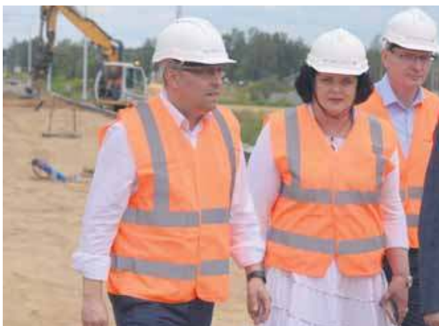
Wojewoda śląski Jarosław Wierzbicki i śląscy posłowie przyglądali się postępowi budowy szybkiej kolei do Międzynarodowego Portu Lotniczego „Katowice” w Pyrzowicach
