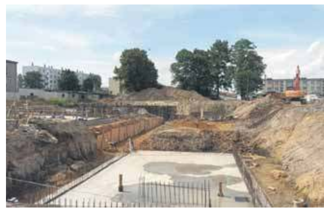
Basen w Radzionkowie w budowie
