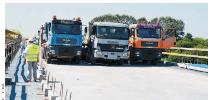
Budowany w ramach trasy S19 nowy most na Sanie przeszedł próby obciążeniowe
