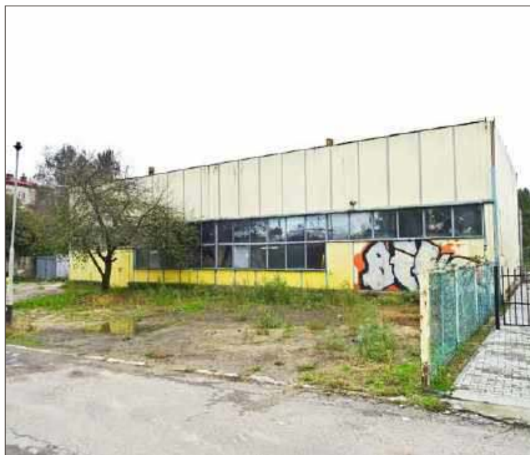
Elektrociepłownia warta ponad 20 mln zł powstanie w tym miejscu.
