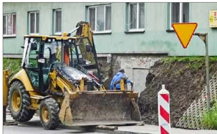
Prace na zewnątrz budynku na razie zostały wstrzymane.
