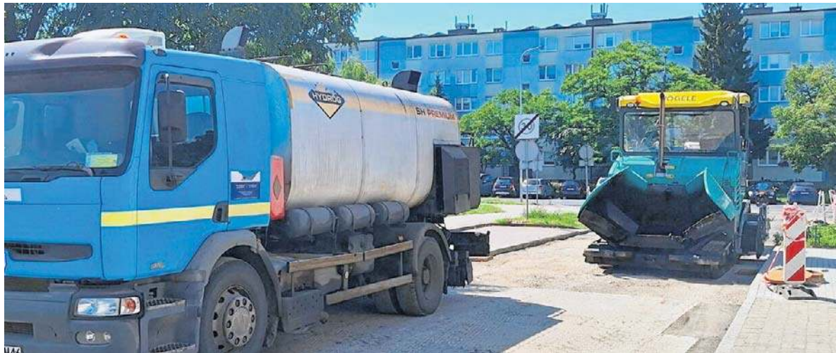
Ulica św. s. Faustyny w Toruniu - w czwartek 30 lipca zjechał tu sprzęt do układania nowego asfaltu
