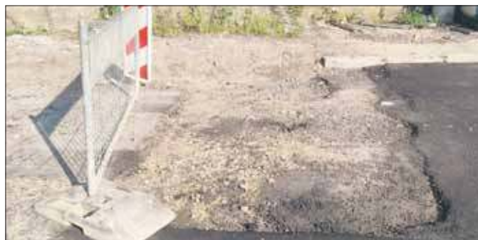
Prace związane z nawierzchnią wydają się być w większości zakończone
