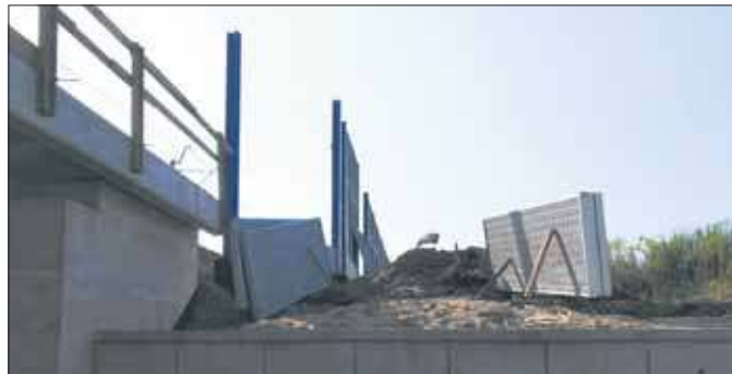
Obecnie montowane są ekrany akustyczne
