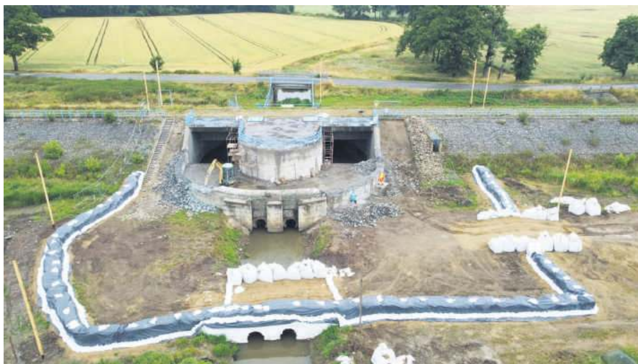
Trwa ostatni etap remontu zbiornika zalewowego w Przewornie. Przebudowywana jest wieża, przez którą odbywa się zrzut wody. Foto: Wojciech Poręba, firma HZBUD
