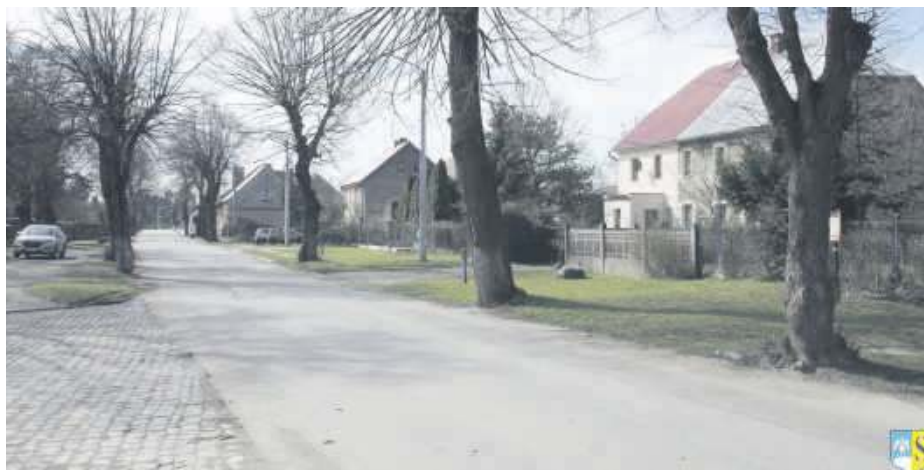
Oprócz nowego odcinka chodnika o długości ok. 500 mb, przy świetlicy wiejskiej ma powstać bezpieczne, wyniesione przejście dla pieszych
