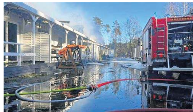
Część konstrukcji runęła pod wpływem wypalenia. Żaden z palących się domków nie nadaje się do zamieszkania
