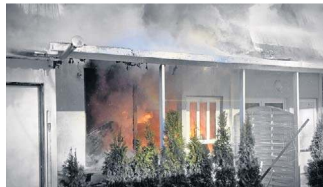
Strażacy określili pożar jako duży i bardzo trudny, bo blaszany dach skumulował ogień wewnątrz budynków
