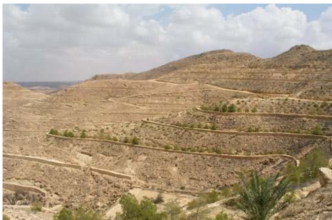
Przeciwoerozyjna zabudowa stoku w okolicach Matmaty w Tunezji
