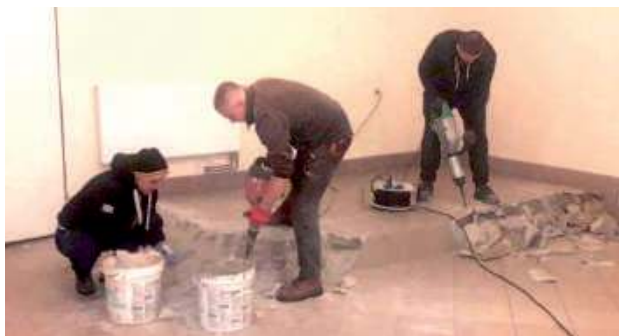
Prace remontowe rozpoczęły się w styczniu
