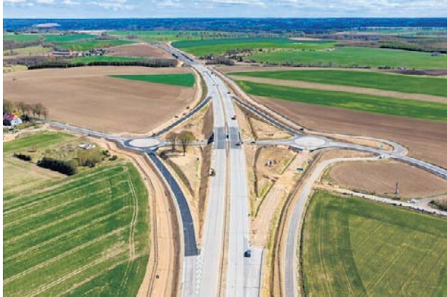
Betonowa nawierzchnia S6 na odcinkach Słupsk - Bobrowniki i Bobrowniki - Skórowo
