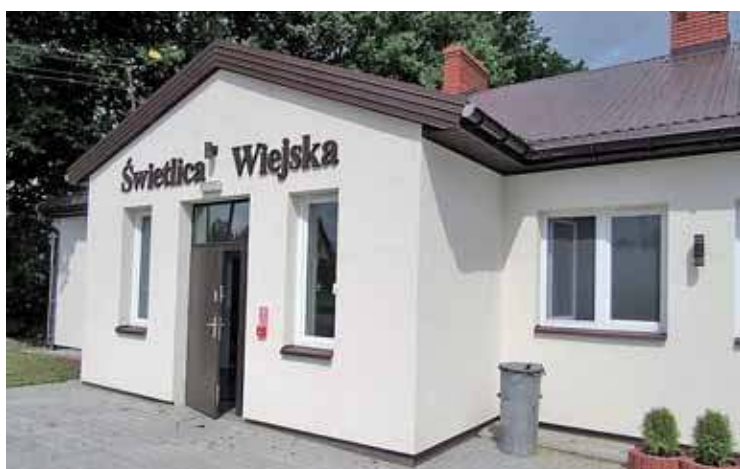
Odnowione z PROW 2014-2020 świetlice wiejskie to często centrum życia lokalnego
