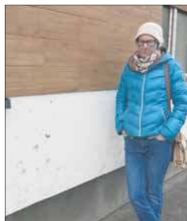
Zniszczona elewacja pani Elżbiety
