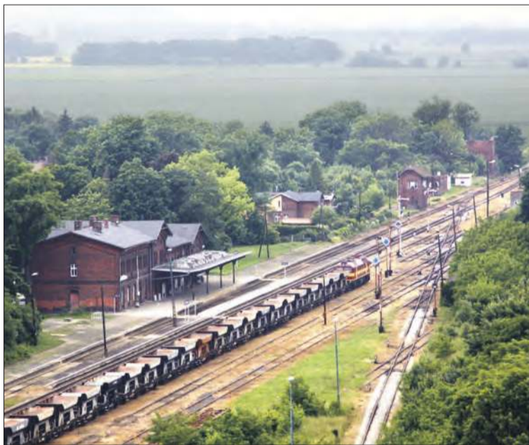
Fotografia z elewatora zbożowego z budynkami kolejowymi i dworcem
