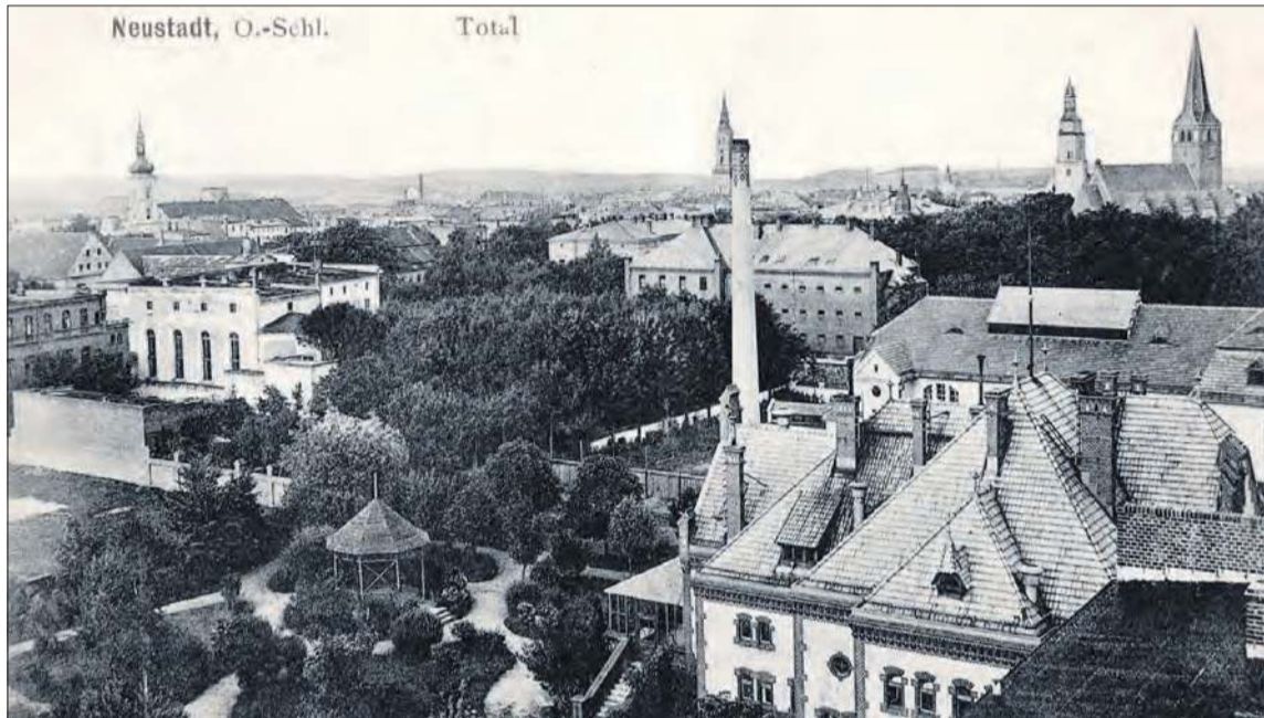
Zdjęcie z wysokiej kamienicy Bödlandera przy skrzyżowaniu ulic Dąbrowskiego i Parkowej. Zwraca uwagę pięknie zagospodarowany ogród kasyna. Widać również tylną ścianę dawnego budynku gospodarczego Urzędu Celnego – obecnie siedziba redakcji Tygodnika Prudnickiego.
